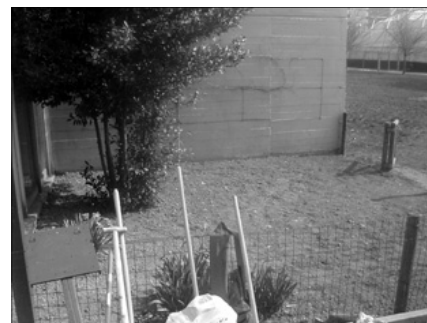
l'orto prima dell'inizio lavori
